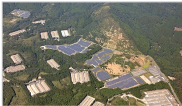
鹿児島県垂水市 9.7MW
